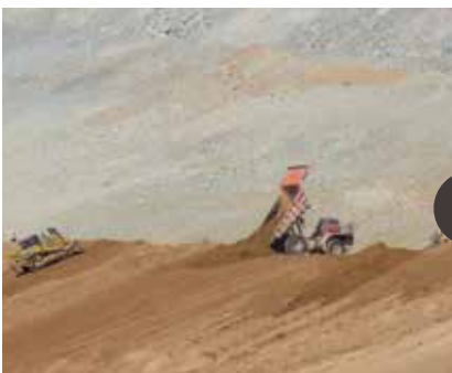
Penyebaran tanah reklamasi
