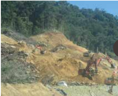
Pengupasan tanah lapisan atas dan bawah
