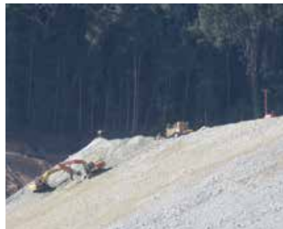
Penyiapan lahan (kontur lereng 2:1)
