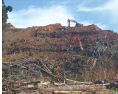
Pemotongan pohon dan pembukaan lahan
