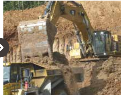
Pengangkutan tanah ke area Reklamasi atau soil stockpile
