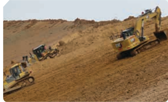
▲ Penempatan tanah (atas) dan pematatan tanah (bawah) menggunakan alat berat.
