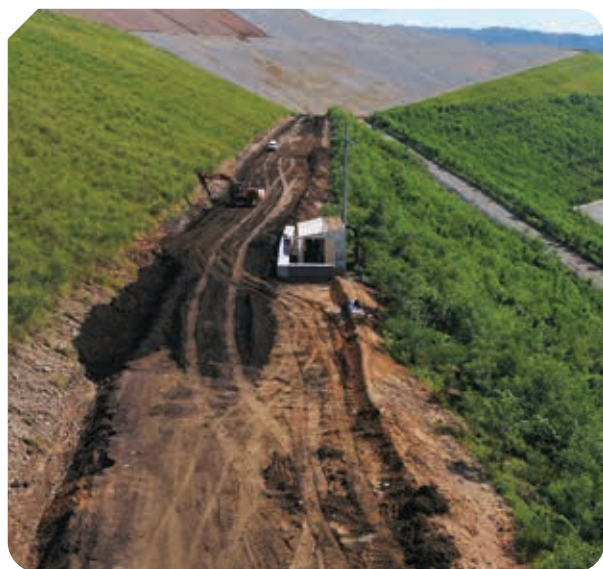
▲ Proses pemanfaatan FABA sebagai bahan dasar jalan meliputi (1) pencampuran FABA dan tanah (2) pengaplikasian campuran pada jalan dan (3) pemadatan campuran.
