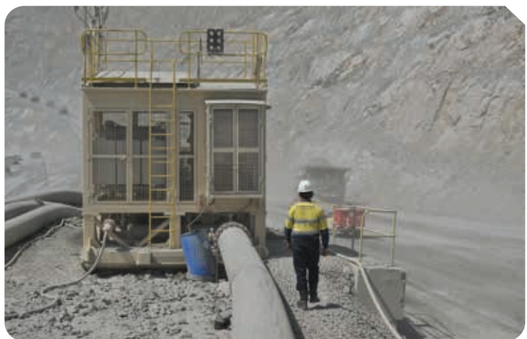
▲ Memanfaatkan air olahan dari SCS sebagai sumber untuk pabrik pengolahan (atas) dan untuk pengairan jalan angkut (bawah).
