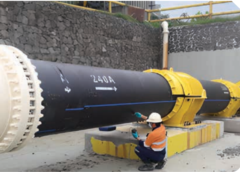
▲ Pemantauan ketebalan pipa Tailing Laut dalam
